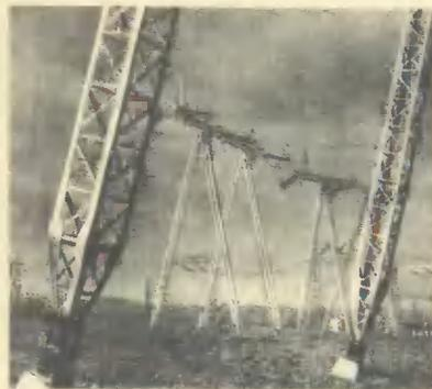
переходе линии через Амур стоят башенные опоры высотой 150 м! А через Обь — 180 м!
